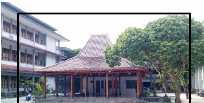
Pembangunan Joglo dan Kantin FMIPA
