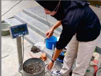
Pembuatan batako dari limbah plastik
